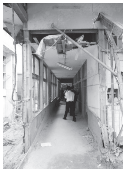
⑥体育館裏校舎の廊下の様子
